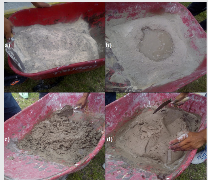
Figura 4. Obtención de la mezcla: a) Mezclado de arena, polvo de mármol y cemento; b) Vertido de agua; c) Mezclado; d) Mezcla homogénea obtenida.
